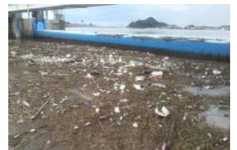
※この写真は芦屋町にある遠賀川河口堰にごみが流れ着いた状況を写したものです。
