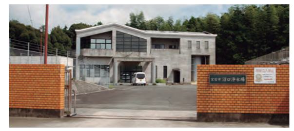
市内に4カ所ある浄水場 (写真は沼口浄水場)
