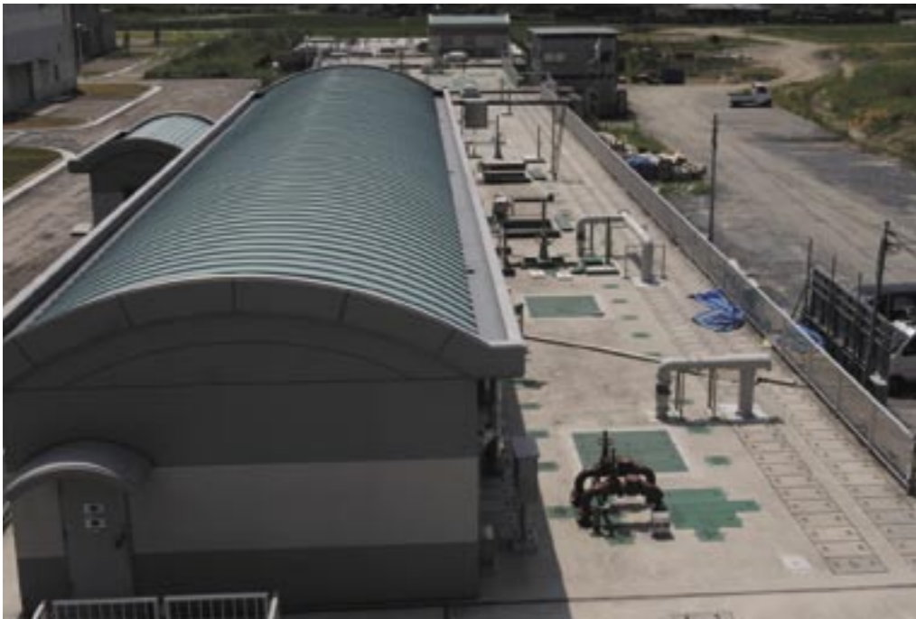
遠賀川中流浄化センター（直方市）
