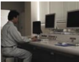
汚水処理工程は、コンピュータにて管理される。
