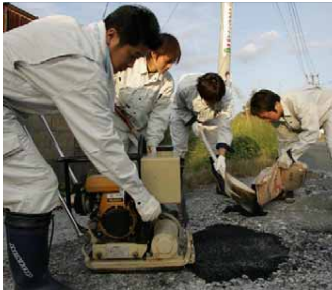
業者に委託することなく、職員でできることは積極的にいった。簡単な道路工事や施設の草刈りなど、お金がない代わりに知恵と体を使った。
