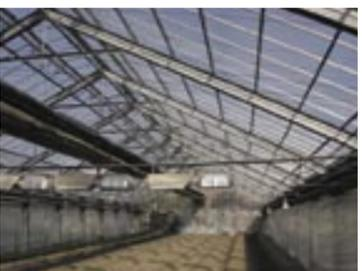
台風被害を受けず、安定した出荷ができる鉄骨のハウスだが、振動と経年劣化には勝てない。「今年で12年が経過し、壁のビニールが一部破れてきよんよ。そこから、強風が吹き込んでくると、天井の換気口からハウスが壊れるのでしっかりと補修をせんとな」と花栽培とは違う所での悩みも多い。
