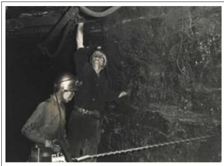
▶坑内での切羽穿孔作業の様子。
