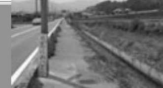
・小伏地区の歩道
