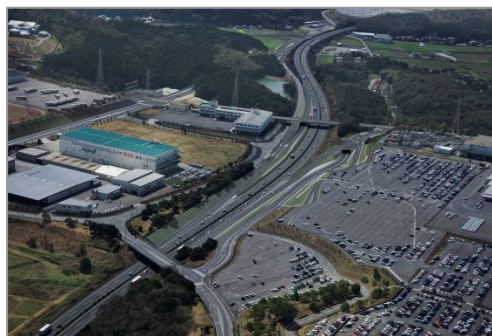
▲スマートインターチェンジ（整備中）
