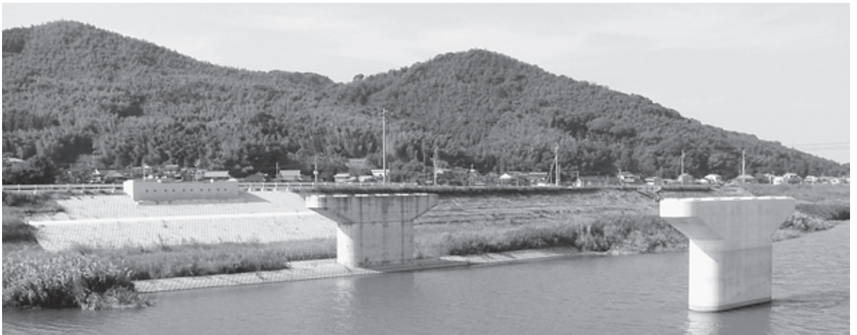
建設中の下口橋
