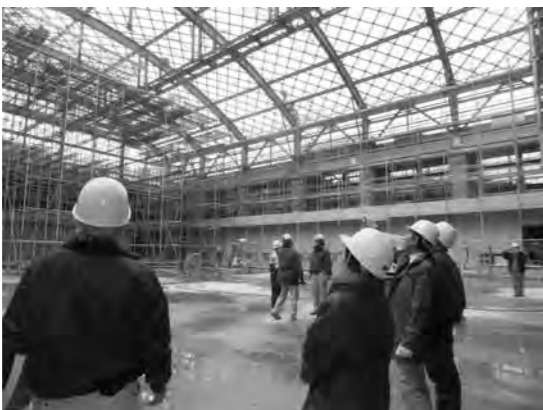
建設中の宮若東中学校
