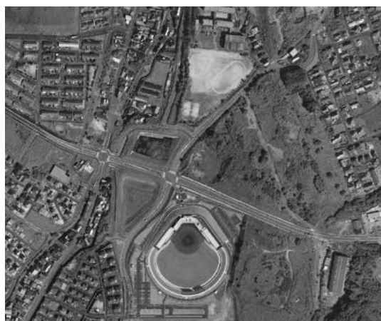
光陵地区住宅地付近航空写真
