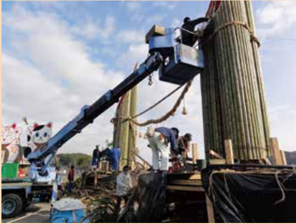
大門松解体作業
