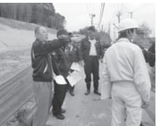
県道室木・下有木・若宮線布設替工事箇所
