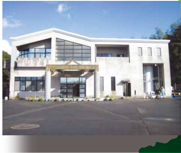
ぬまぐちじょうすいじょう 沼口浄水場
