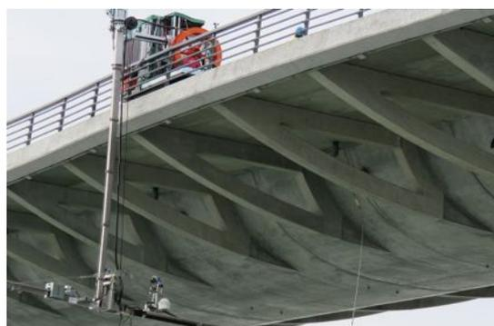
写真2.橋梁点検支援ロボット
