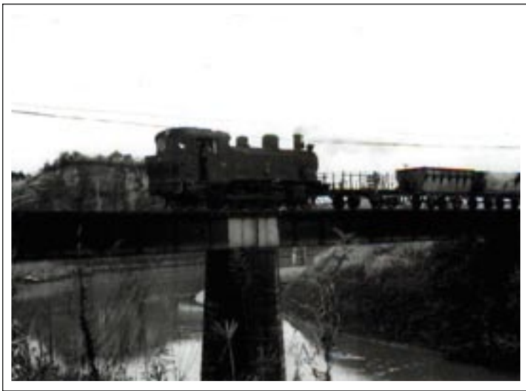
→勢いよく黒煙を上げながら走る充填汽車。掘った穴を埋める砂を運搬する役割を担っていました。
